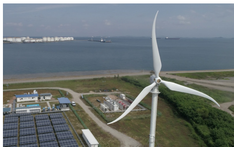
La plateforme REIDS-SPORE : un microgrid pour l'autonomie énergétique des sites isolés, ici sur l'île de Semakau, à Singapour.
