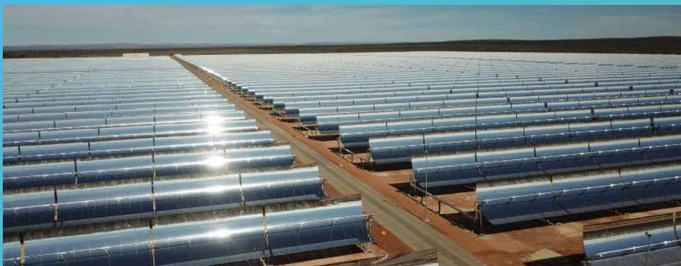
Le parc solaire d'ENGIE à Kathu, en Afrique du Sud, est un des plus grands projets renouvelables du pays, avec une capacité installée de 100 MW. C'est une centrale solaire thermodynamique à concentration (CSP) dotée de la technologie cylindro-parabolique et équipée
