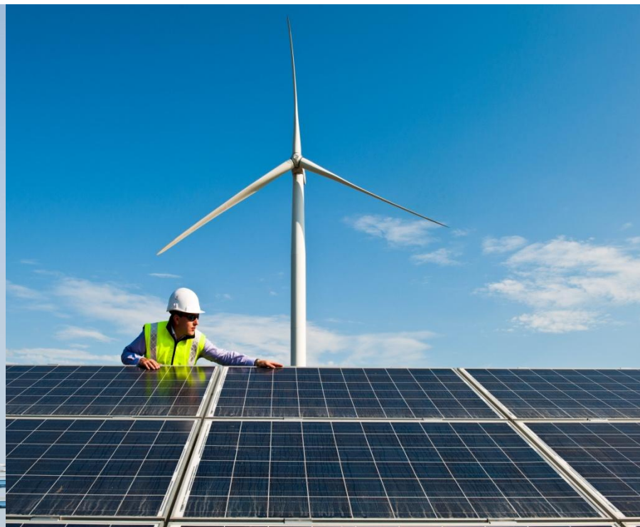
Parc photovoltaïque de Bollene, France
