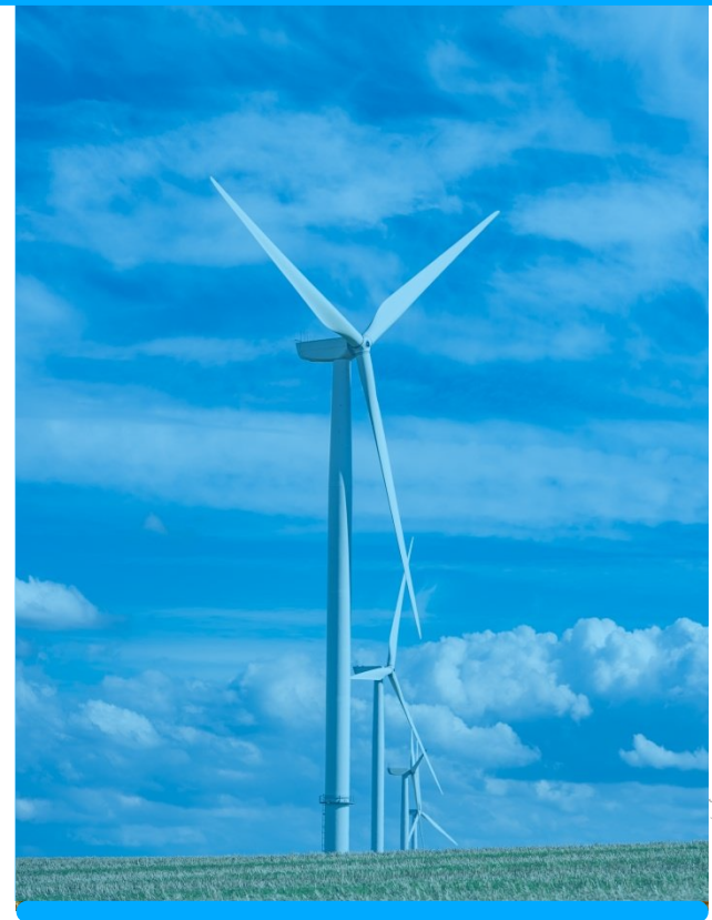
Parc éolien - Germinon-Vélve, France
