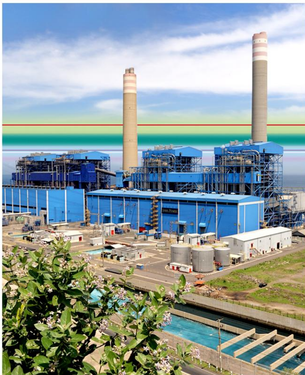
Centrale à charbon de Paiton, Indonésie
